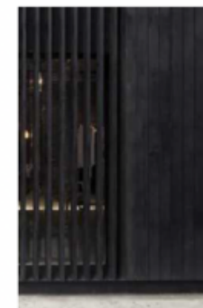
Holzfassade, OG dunkel
